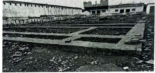
सी.एच.सी. मडावरा में निर्माणाधीन बी.पी.एच.यू. भवन
